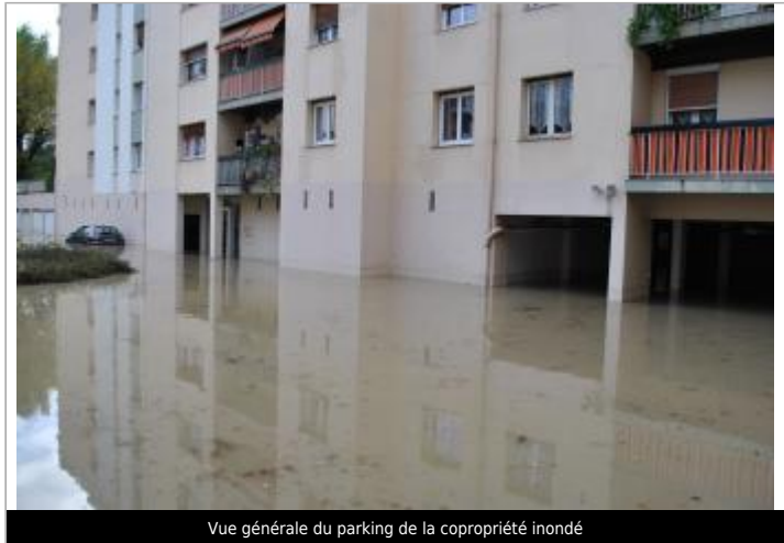
Vue générale du parking de la copropriété inondé
