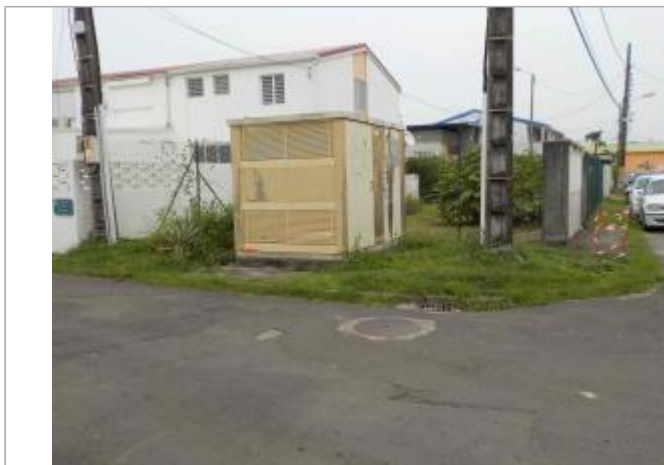
Vue du site- Auteurs : DEAL, ONF et témoignages
