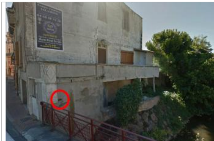
Vue du site
