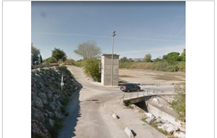
rive gauche poste de relevage à coté du passage à gué
