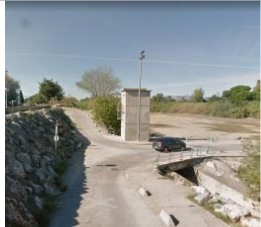
rive gauche poste de relevage à coté du passage à gué
