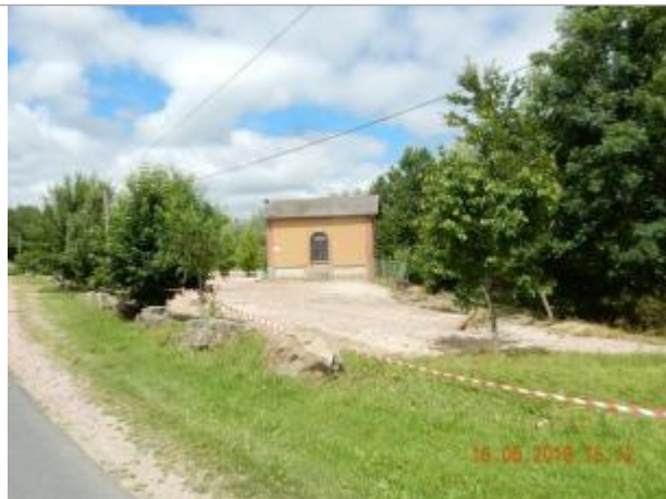
Le boulodrome à l'amont (photo SPC SACN)
