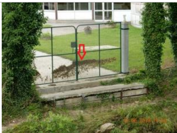
Dépôt de brindilles sur la clôture de la salle communale (photo SPC SACN)
