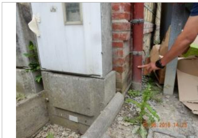
Dépôt de brindilles sur la gouttière (photo SPC SACN)
