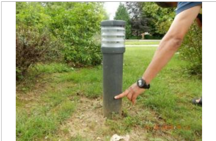
Dépôt de brindilles sur l'éclairage au sol (photo SPC SACN)
