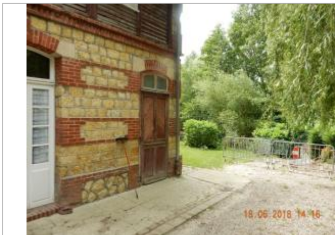
Bâtiment à proximité de la passerelle sur la Vie (photo SPC SACN)
