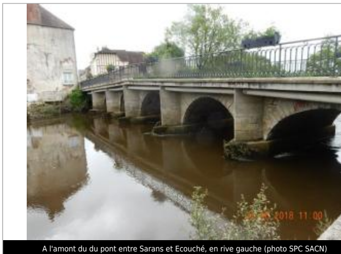
A l'amont du pont entre Sarans et Ecouché, en rive gauche (photo SPC SACN)
