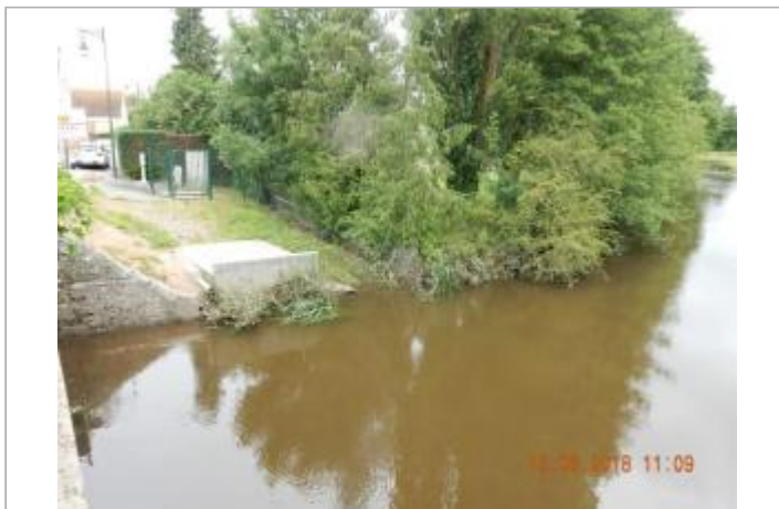
A l'amont du pont entre Ecouché et Serans, en rive droite (photo SPC SACN)
