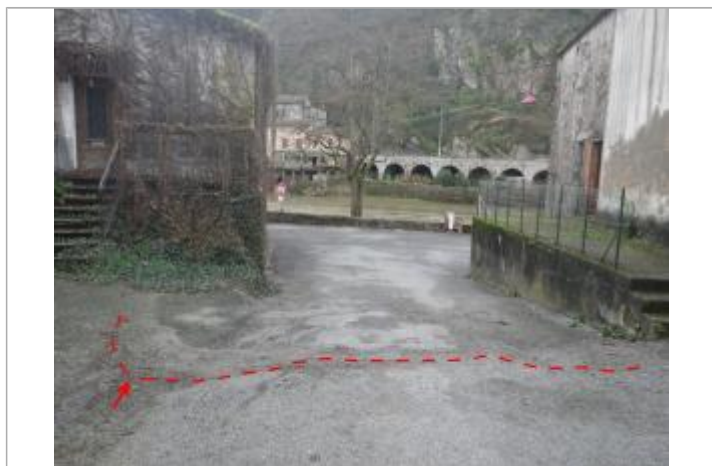
Vue de la laisse d'inondation - Auteur : AGERIN
