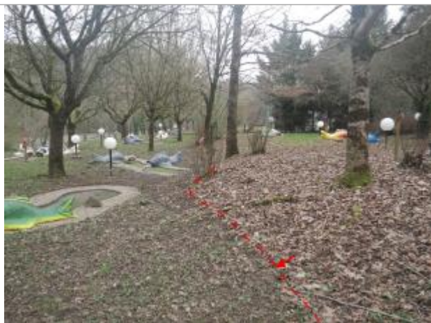
Vue de la laisse d'inondation - Auteur : AGERIN
