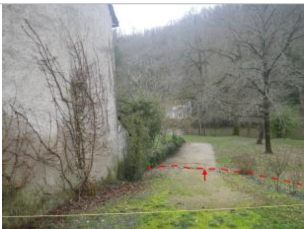
Vue de la laisse d'inondation - Auteur : AGERIN
