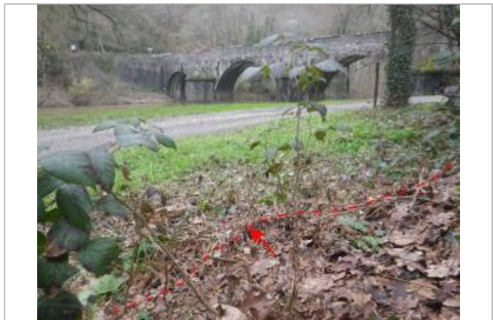
Vue de la laisse d'inondation - Auteur : AGERIN
