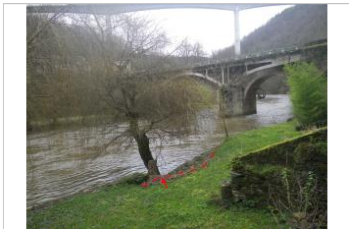
Vue de la laisse d'inondation - Auteur : AGERIN
