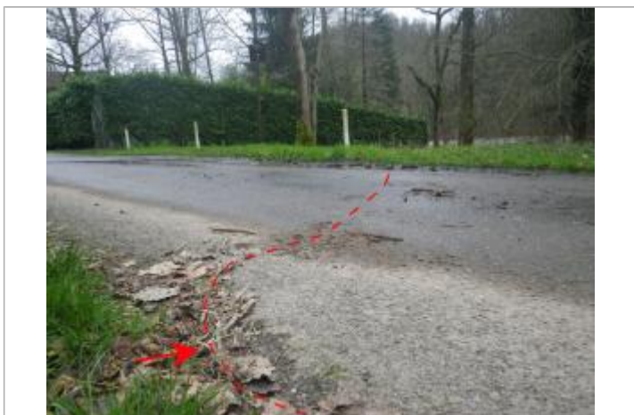
Vue de la laisse d'inondation - Auteur : AGERIN
