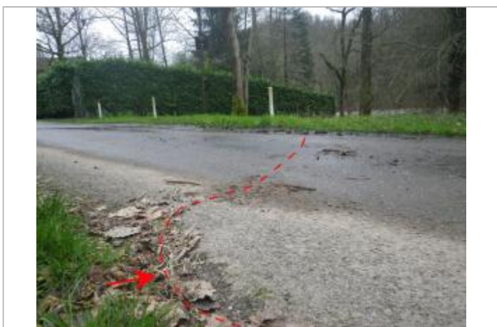
Vue de la laisse d'inondation - Auteur : AGERIN
