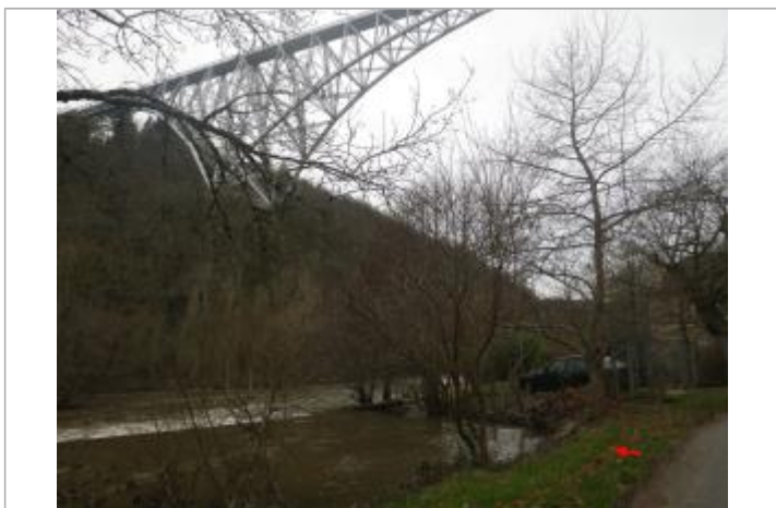
Vue de la laisse d'inondation - Auteur : AGERIN
