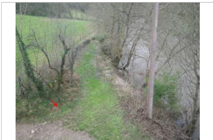
Vue de la laisse d'inondation - Auteur : AGERIN
