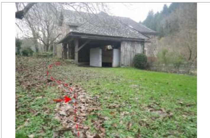
Vue de la laisse d'inondation - Auteur : AGERIN
