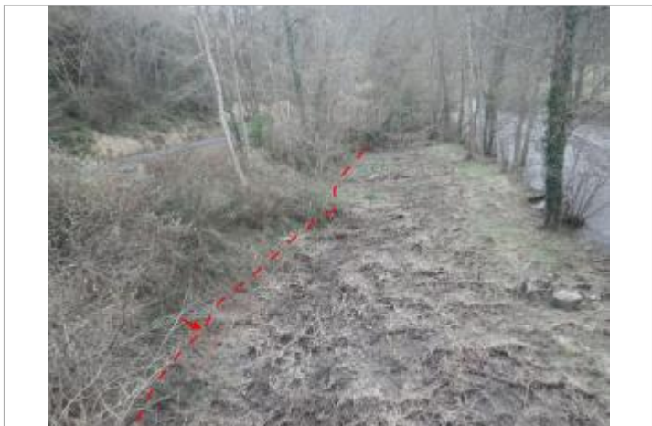
Vue de la laisse d'inondation - Auteur : AGERIN
