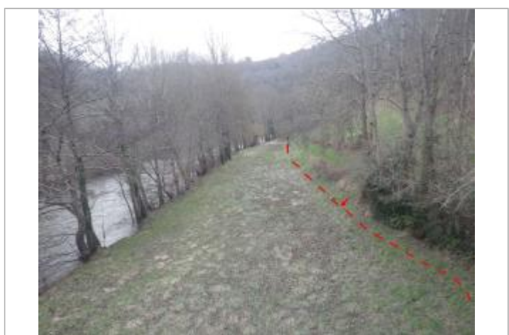
Vue de la laisse d'inondation - Auteur : AGERIN
