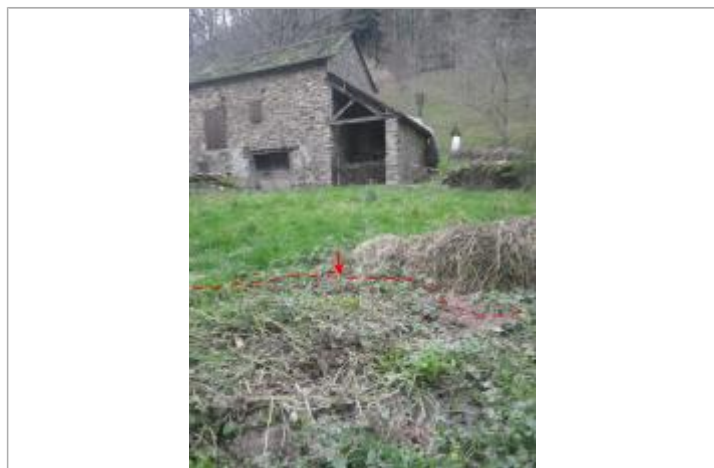
Vue de la laisse d'inondation - Auteur : AGERIN
