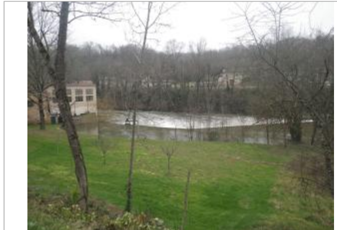
Vue du site - Auteur : AGERIN
