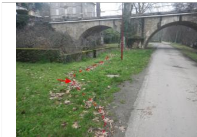
Vue de la laisse d'inondation - Auteur : AGERIN
