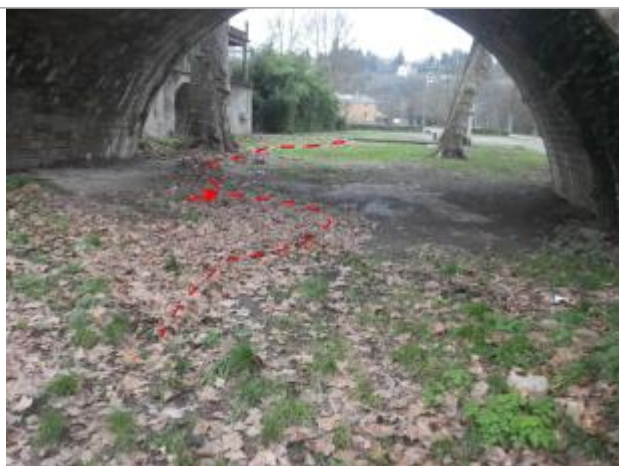
Vue de la laisse d'inondation - Auteur : AGERIN
