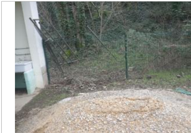
Vue du site - Auteur : AGERIN
