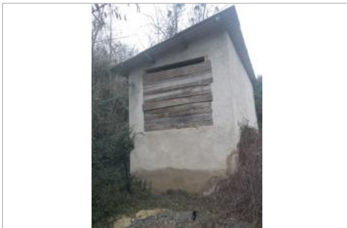
Vue du site - Auteur : AGERIN
