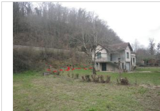
Vue de la laisse d'inondation - Auteur : AGERIN
