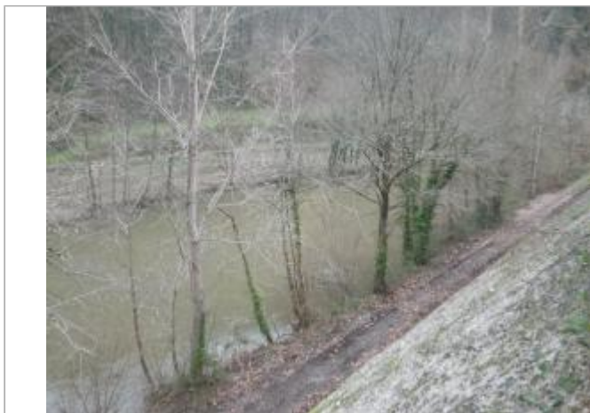
Vue du site - Auteur : AGERIN
