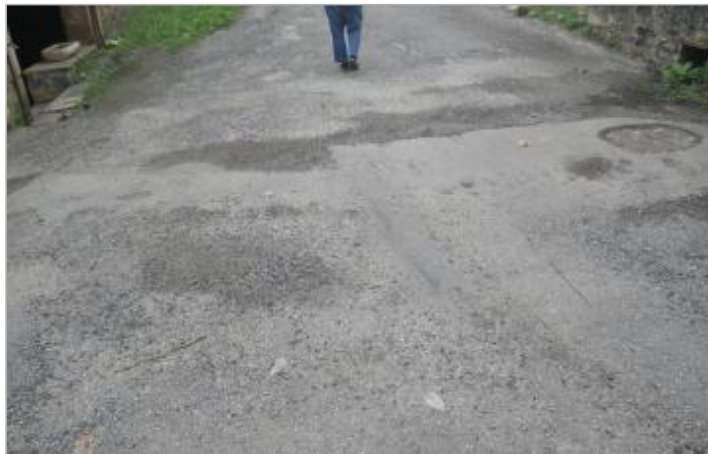
Vue du site - Auteur : AGERIN
