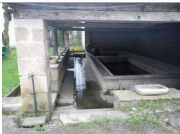
Vue de la laisse d'inondation - Auteur : AGERIN
