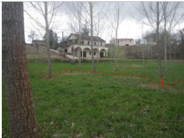
Vue de la laisse d'inondation - Auteur : AGERIN
