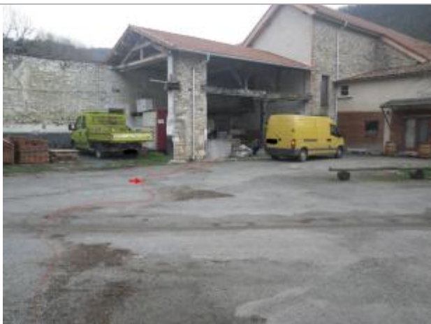
Vue de la laisse d'inondation - Auteur : AGERIN
