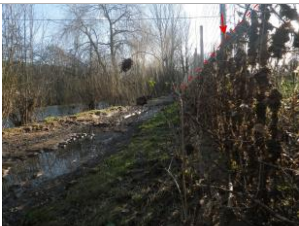
Vue de la laisse d'inondation - Auteur : AGERIN
