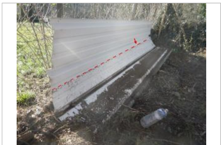
Vue de la laisse d'inondation - Auteur : AGERIN
