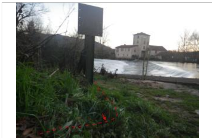
Vue de la laïsse d'inondation - Auteur : AGERIN
