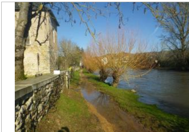
Vue du site - Auteur : AGERIN
