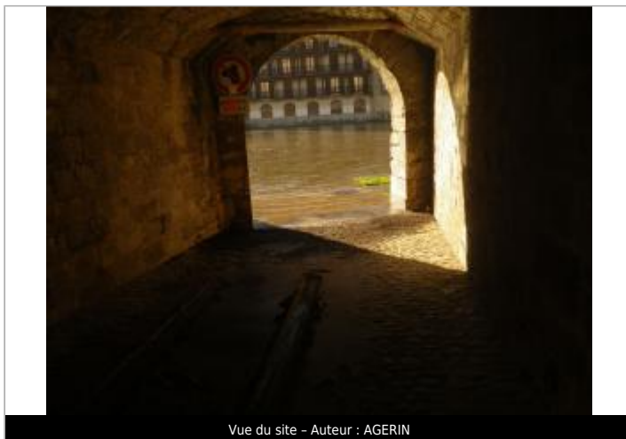
Vue du site - Auteur : AGERIN
