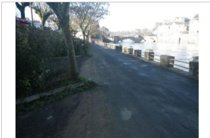
Vue du site - Auteur : AGERIN
