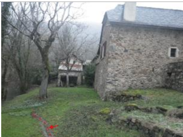
Vue de la laisse d'inondation - Auteur : AGERIN
