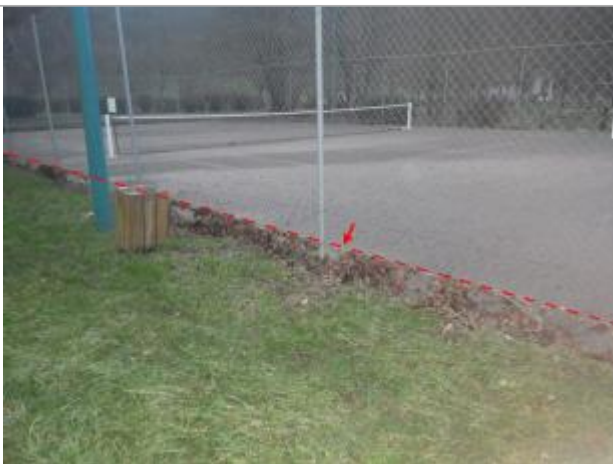
Vue de la laisse d'inondation - Auteur : AGERIN
