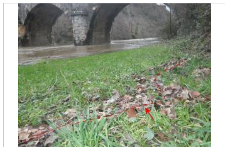
Vue de la laisse d'inondation - Auteur : AGERIN
