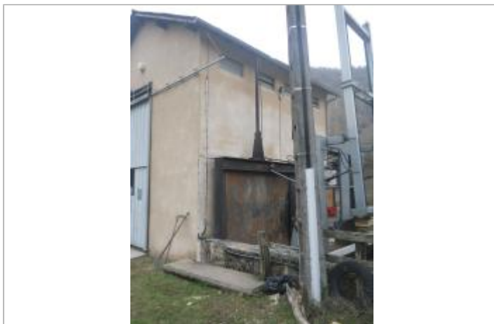
Vue du site - Auteur : AGERIN
