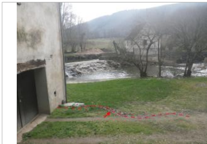
Vue de la laisse d'inondation - Auteur : AGERIN
