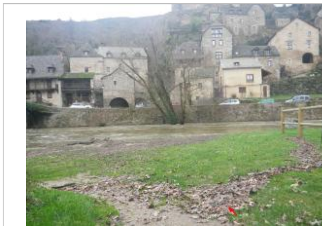
Vue de la laisse d'inondation - Auteur : AGERIN
