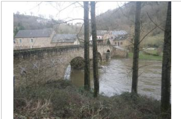
Vue du site - Auteur : AGERIN
