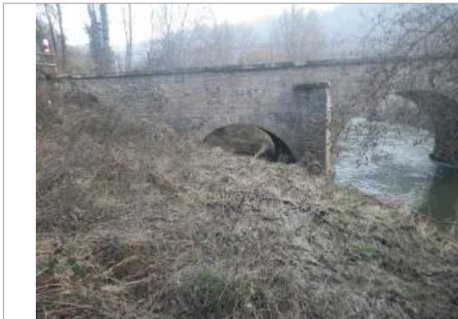
Vue du site - Auteur : AGERIN
