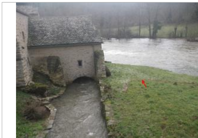
Vue de la laisse d'inondation - Auteur : AGERIN
