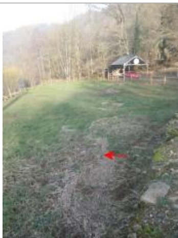
Vue de la laisse d'inondation - Auteur : AGERIN
